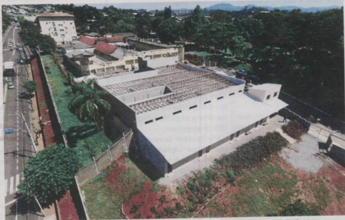
Com 80% das obras concluídas, presídio feminino precisa de mais R$ 250 mil. Lajeado foi o que mais destinou recursos
