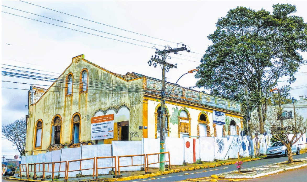
Casa Vidal, que passa por processo de restauro, abrigará no futuro a sede do Museu Histórico Municipal
