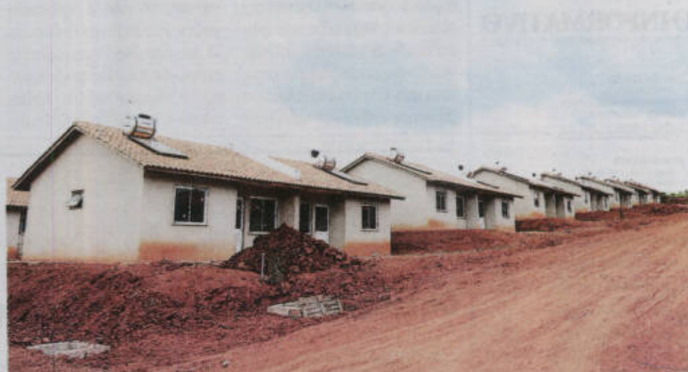
ESTRELA: 250 casas estão sendo levantadas na localidade de Novo Paraíso
