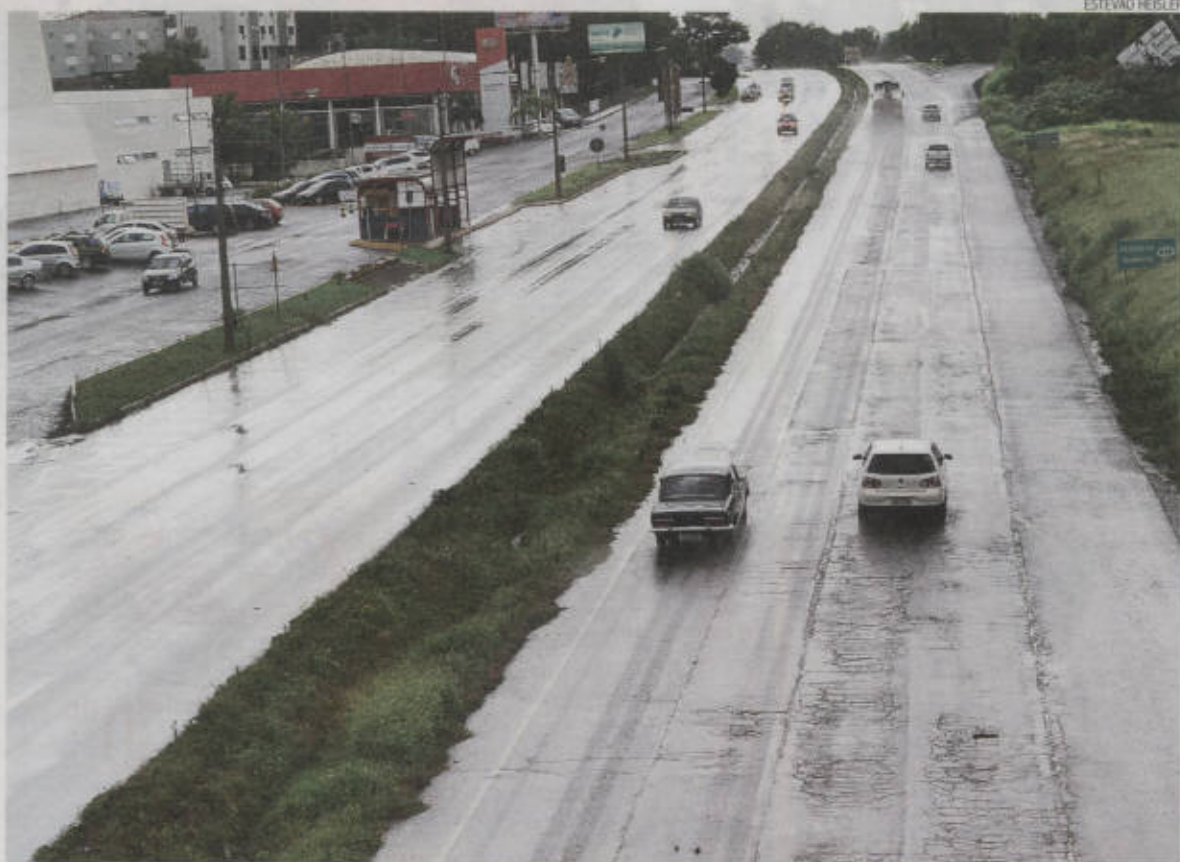
Obra começa neste ano entre Soledade e Tabai, numa extensão de 152,4 quilômetros. Previsão é de 24 meses
