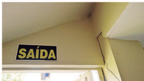
Saída no primeiro andar também foi atingida pelo desnível de construção
