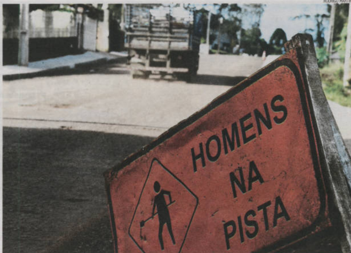
Na rua Pedro Petry, no Universitário, serviços realizados pelo consórcio terão que ser refeitos após oito meses de paralisação
