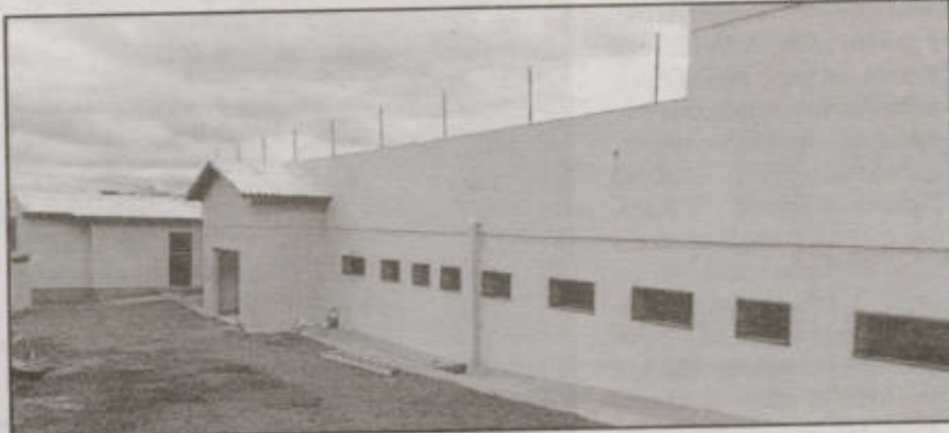
Parte dos fundos do prédio
