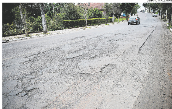
Irregularidades do asfalto devem ser resolvidas com recapeamento
