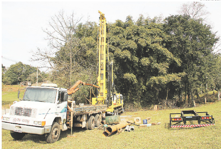
Equipamento deve agilizar as obras em até 30 dias
