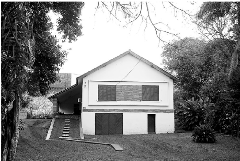
ABRIGO: casa de acolhida está localizada na Rua Julio de Castilhos, em frente da Farmácia-Escola
