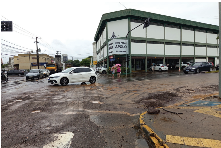
Interrupção no trecho começou na semana passada para obras da Corsan
