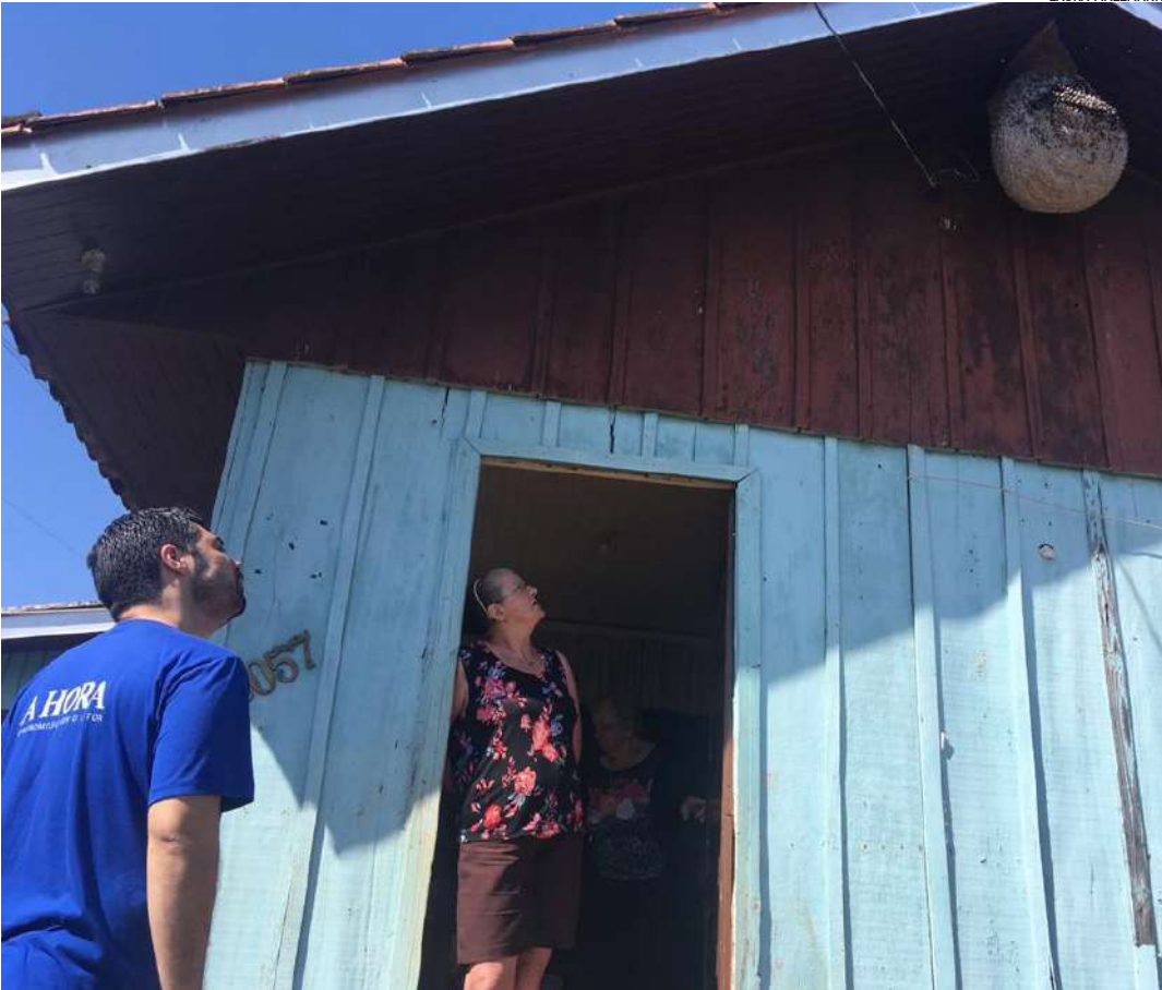
Abelhas fizeram ninho em uma residência às margens da ERS-421. Morado já acionou o poder público
