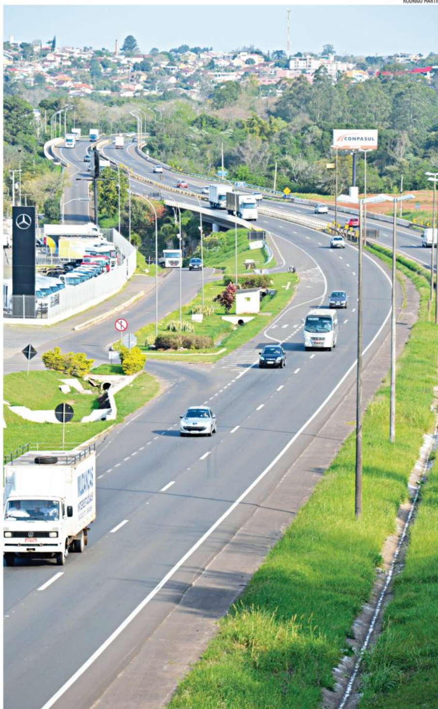
No trecho urbano entre Lajeado e Estrela, a ANTT confirma a construção de uma terceira faixa paralela à BR-386, interligando as duas cidades. Com isso, a ponte sobre o Rio Taquari também será ampliada, tudo isso em um prazo máximo de cinco anos após a assinatura do contrato
