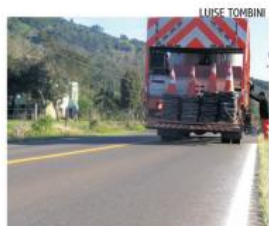
Empresa faz a pintura de todas as faixas e quebra-molas
