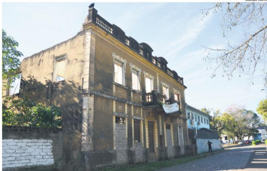
Casa foi parcialmente destruída em setembro de 2013, após incêndio. Desde então, situação só piorou
