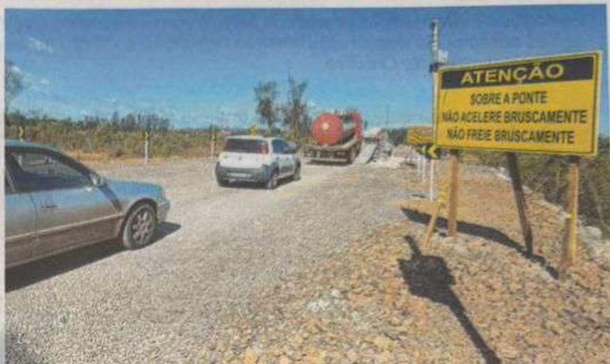
Ponte do Exército, instalada em agosto de 2024 e desativada em 6 de maio de 2025, foi essencial para retomada do fluxo na região, registrando passagem de mais de 700 mil veículos no período
