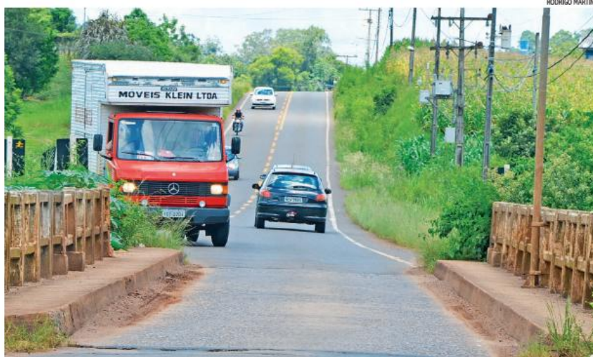
Conforme estimativas do comando rodoviário da BM, passam em média três mil veículos por dia sobre a ponte do Saraquá
