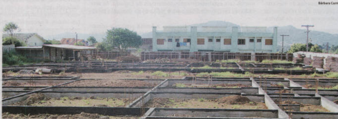
OBRAS: estrutura aguarda recomeço da construção da Emei
