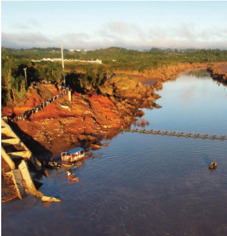
Travessia emergencial para pedestres foi instalada pelo Exército
