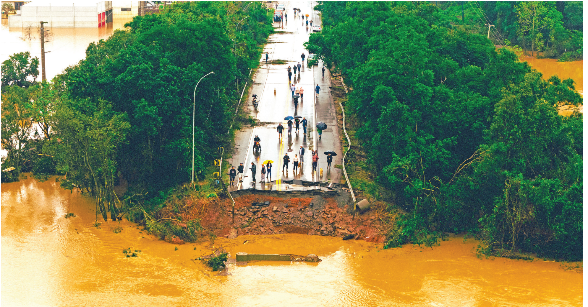
Quando o nível do Forqueta começou a baixar, ainda na quinta-feira, uma das principais marcas daquela tragédia foi revelada: a queda da ponte da ERS-130, na ligação com Arroio do Meio
