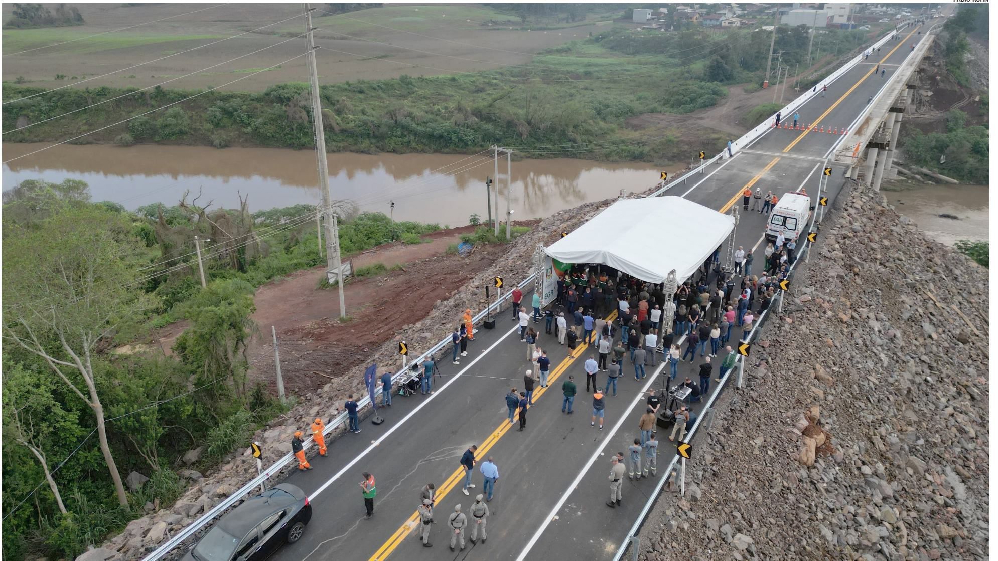
Menos de um ano depois, travessia foi reconstruída pela EGR e entregue para uso da comunidade em abril de 2025. Foi construída em uma cota mais elevada à marca alcançada pelo rio
