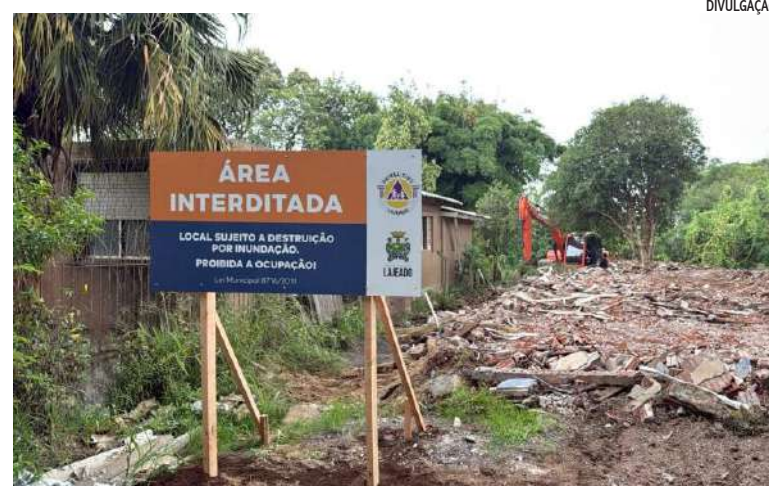
Primeiras demolições ocorreram em áreas de propriedade do município
