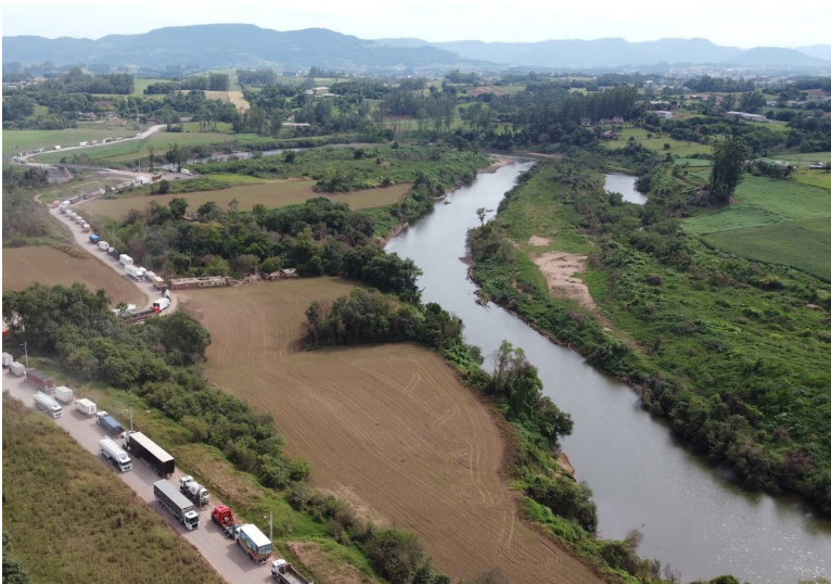
Pavimentação e nova ponte entre Lajeado e Arroio do Meio, onde funcionou a Ponte do Exército, devem desafogar ERS-130 e a reconstruída Ponte de Ferro
