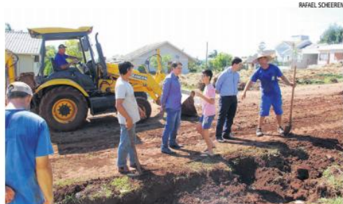
Na companhia de Jung, prefeito Caumo visitou obras no bairro Conventos
