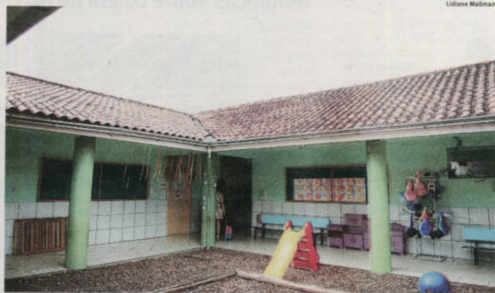
JEITO DE CRIANÇA: telhado da escola receberá a instalação das placas fotovoltaicas
