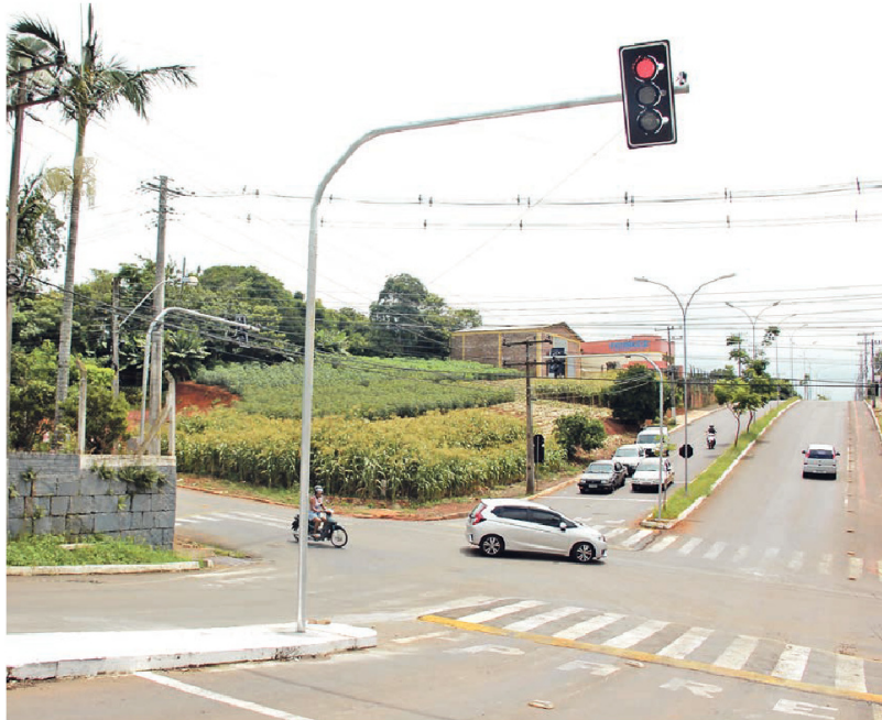
SINALEIRAS: Lajeado conta agora com 40 semáforos
