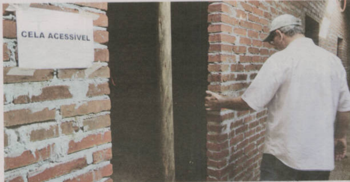
Para Alsepro, construção realizada pela comunidade tem qualidade superior às obras do poder público no setor
