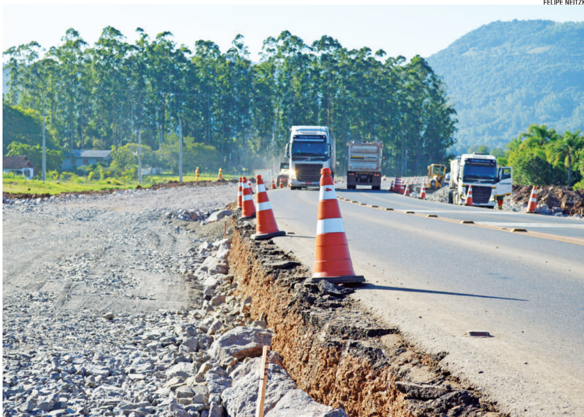
CCR ViaSul prepara trecho de 1,5 quilômetro da duplicação da BR-386 para receber pavimentação
