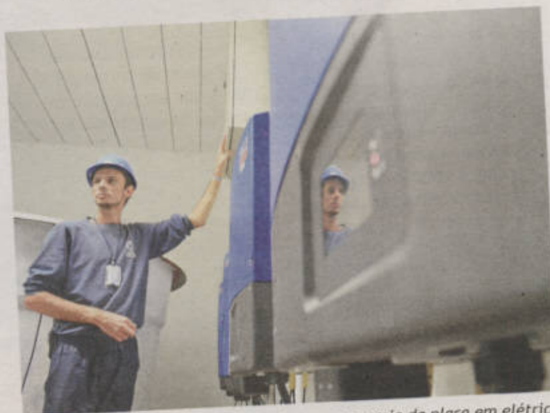
O inversor é responsável por transformar a energia da placa em elétrica
