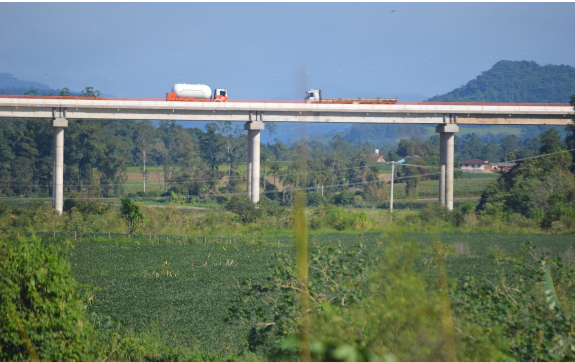
Nova ponte foi projetada para servir de rota alternativa para veículos pesados entre a passagem da ERS-130 e a Ponte de Ferro
