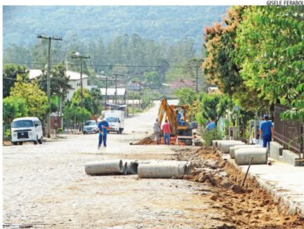
Secretaria de Obras e Viação prepara base da rua para receber asfalto
