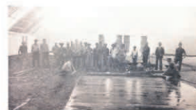
Construção do CEM iniciou no segundo semestre de 1974
