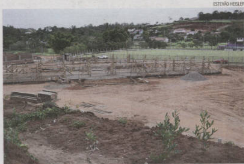
Terreno será preparado pelo governo para a construção do terceiro prédio
