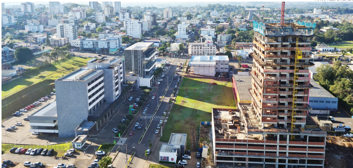
Novo prédio residencial de 38 andares e mais de 130 metros de altura é um dos empreendimentos em construção
