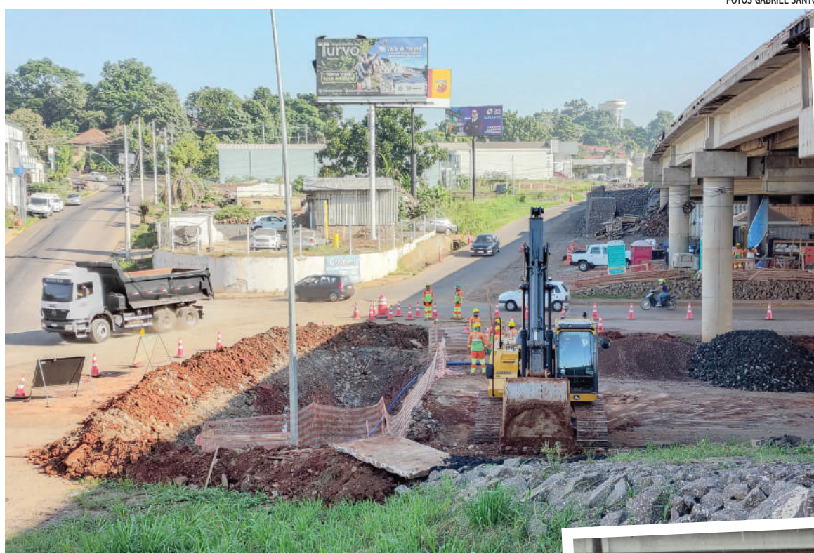
Trabalho de escavação iniciou nesta semana. Serão instaladas novas tubulações no local para evitar alagamentos
