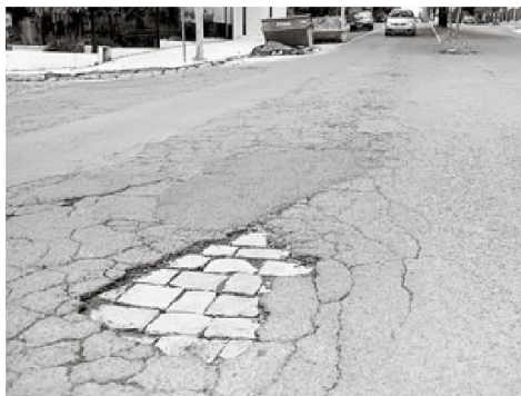
MOINHOS: buracos se unem às rachaduras no asfalto e aos trechos remendados na Avenida Sete de Setembro
