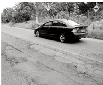
MOINHOS: buracos se unem às rachaduras no asfalto e aos trechos remendados na Avenida Sete de Setembro
