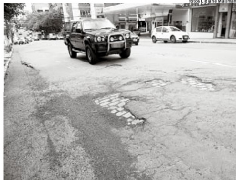
CENTRO: buracos no asfalto mostram o paralelepípedo na Avenida Benjamin Constant
