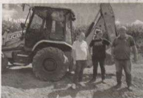
Na propriedade dos Schwarzer, município executou terraplenagem para a construção de um novo galpão e, nesta semana, a máquina trabalha em um acesso.
