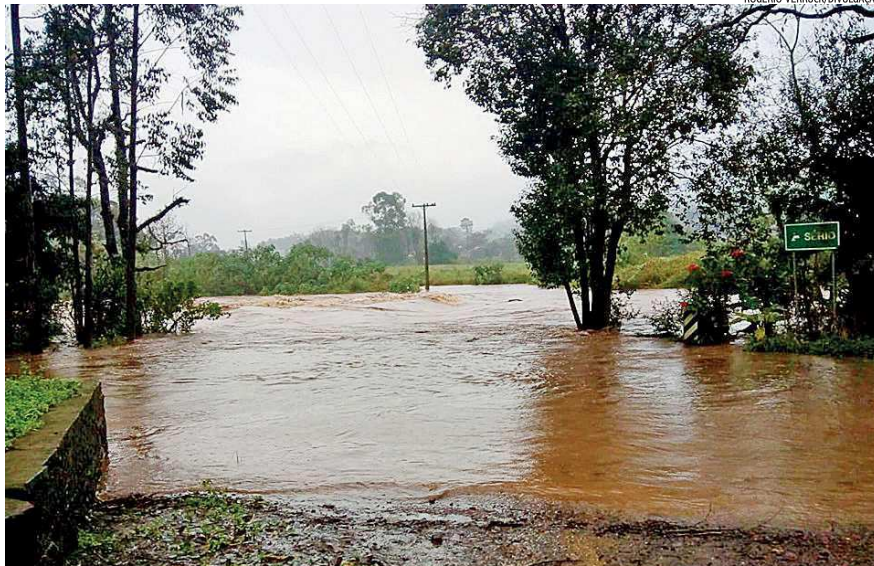
Grande volume de chuva obrigou interdição de ponte no interior de Forquetinha
