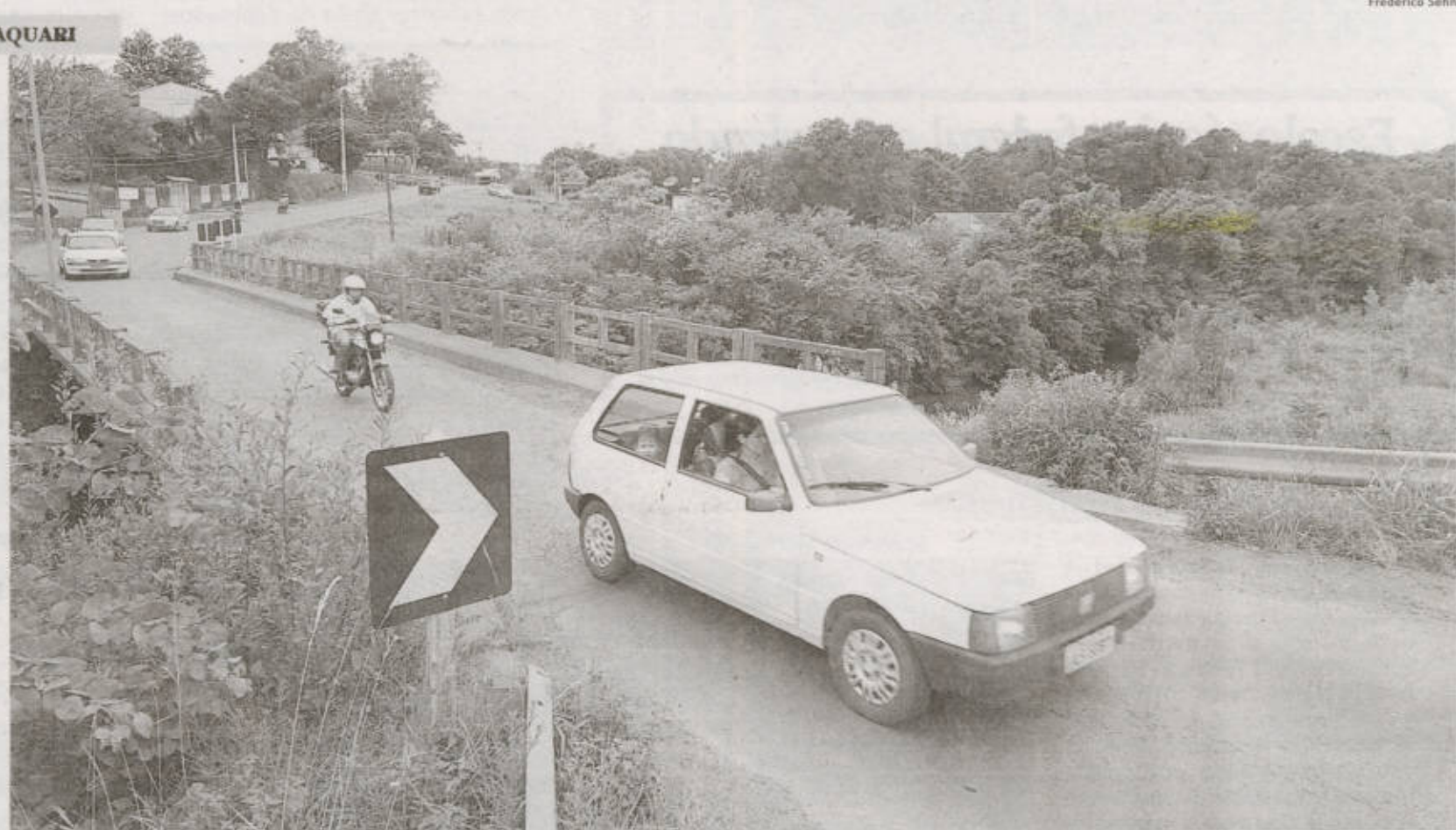
Nova estrutura terá capacidade para suportar 45 toneladas
