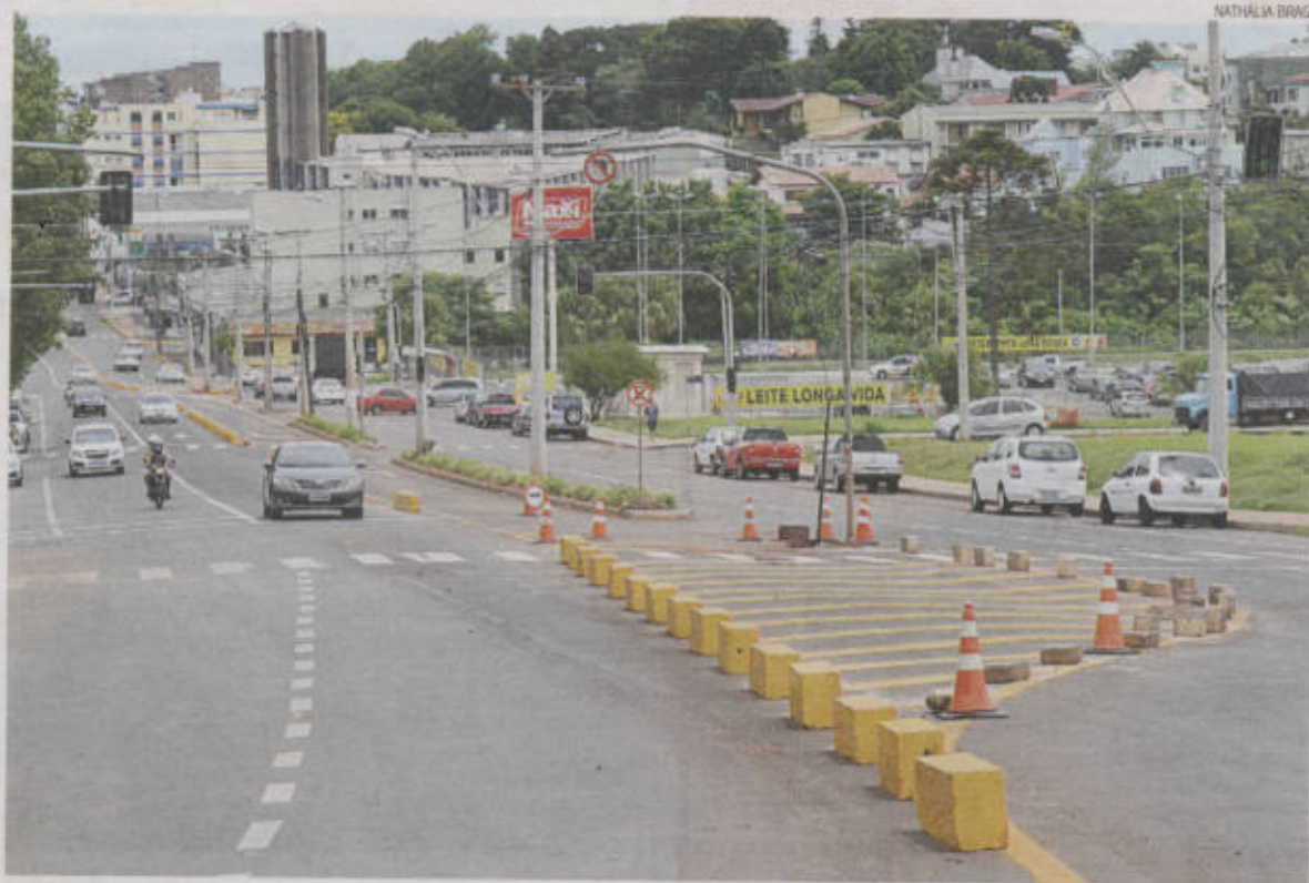
Após término das obras, previsto para esta semana, fiscais de trânsito orientam condutores a seguir no trecho modificado
