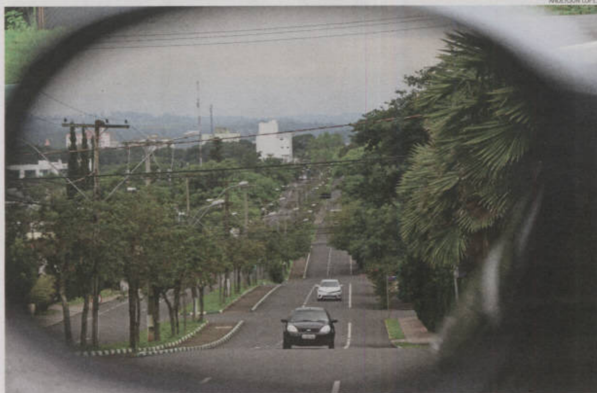
Trecho de um quilômetro no Alto do Parque foi asfaltado em outubro de 2014. Desde então moradores aguardam lombadas
