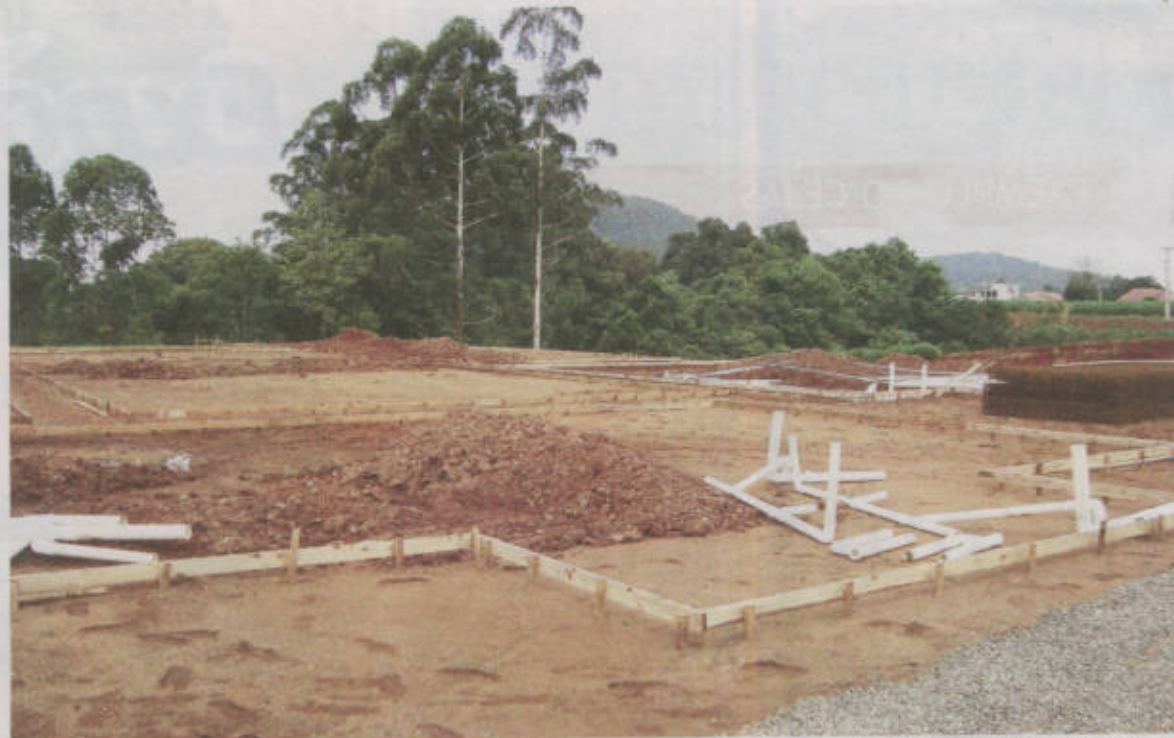
Demarcação do terreno começou na semana passada. Prazo para construção da creche obra tem prazo de dez meses
