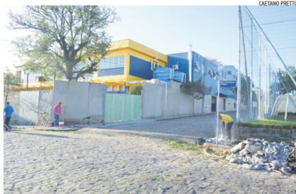
Portões foram retirados ontem. Serviço foi contratado pelo colégio
