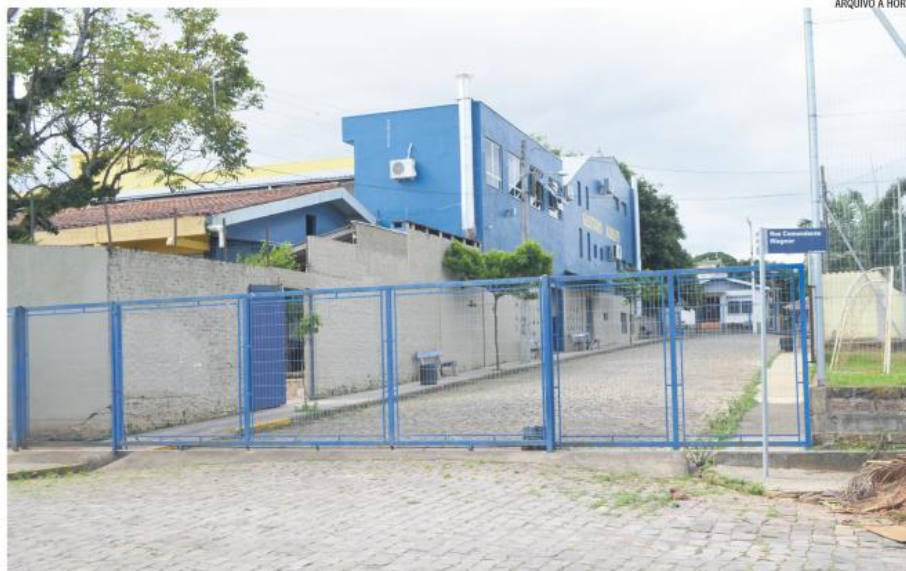
Portões trancavam a passagem de veículos e pessoas no trecho entre as ruas Miguel Tostes e Comandante Wagner
