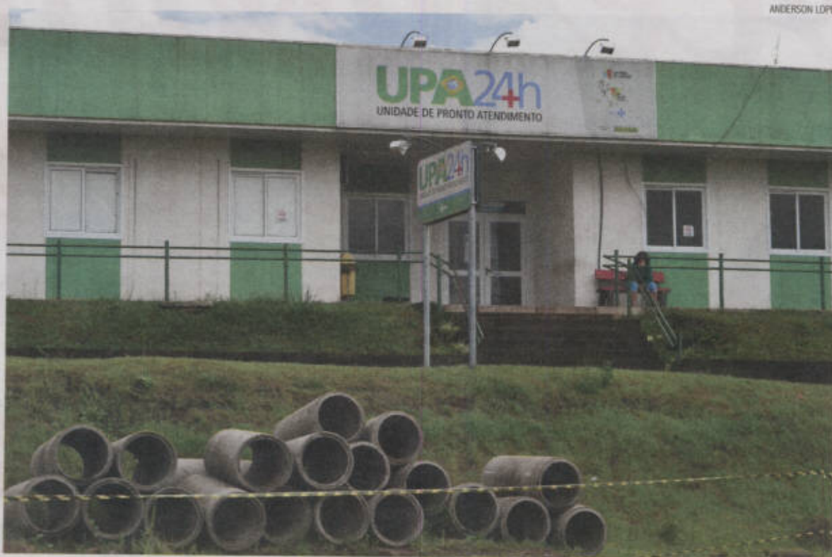
Substituição do sistema de captação pluvial deve aumentar vazão de efluentes e evitar vazamento de resíduos
