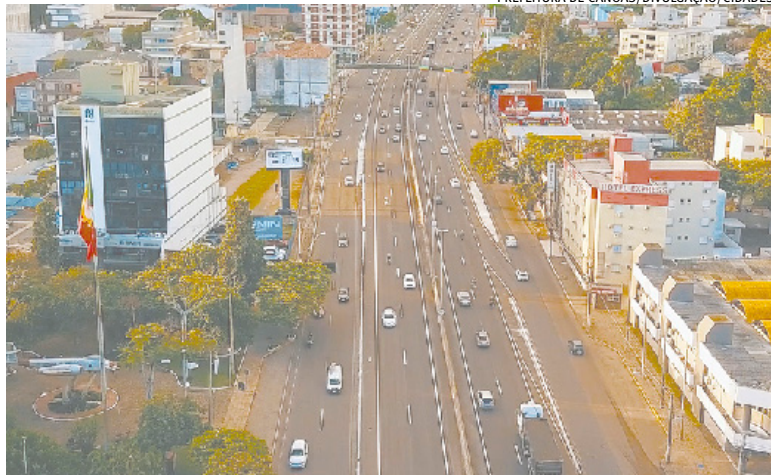
Prefeitura fará a instalação de 440 luminárias de LED no canteiro central
