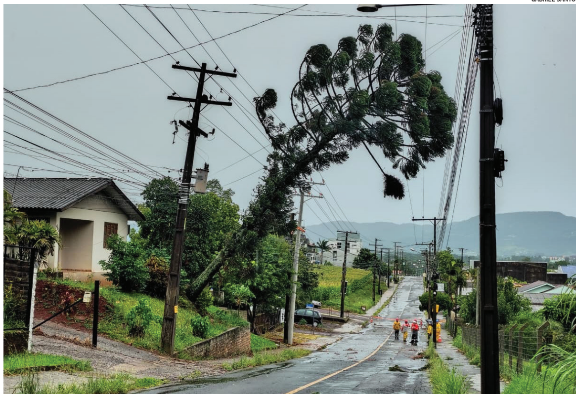
Araucária caiu sobre a rede de energia e deixou o bairro Universitário, em Lajeado, sem energia elétrica
