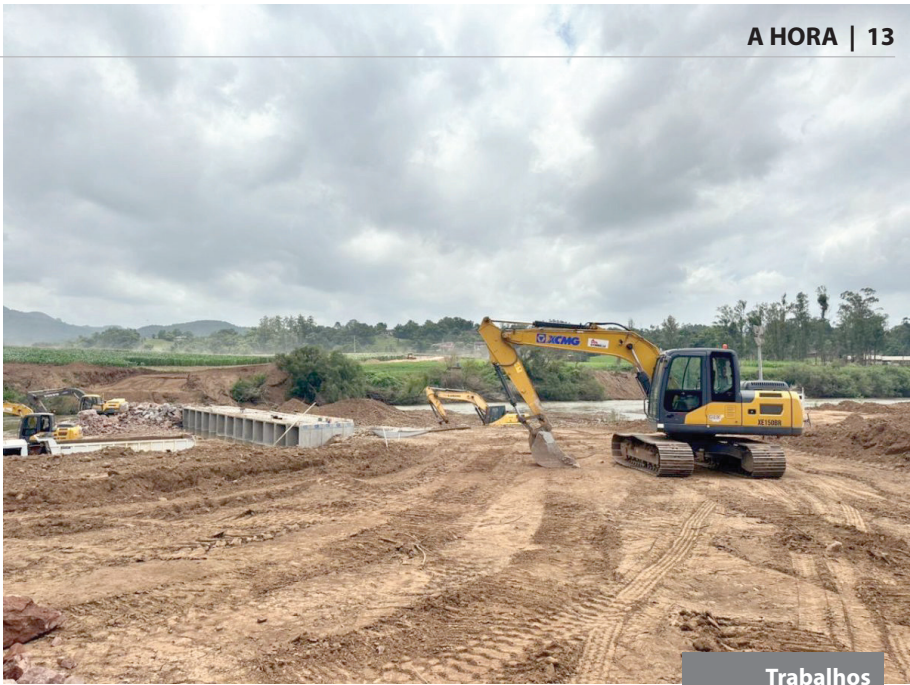
Trabalhos seguem avançados às margens do Rio Forqueta
