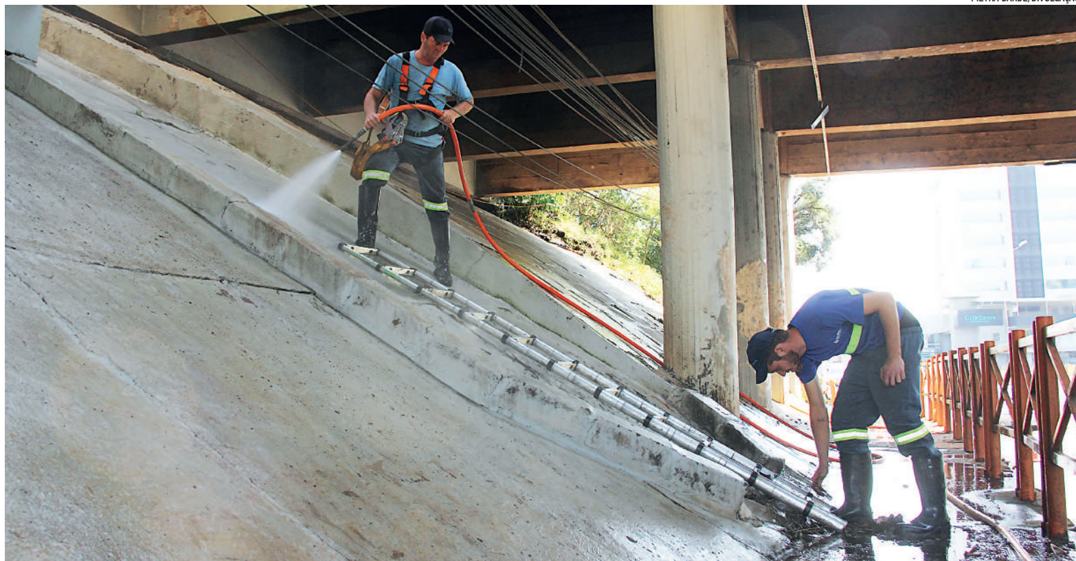
Equipe trabalha na limpeza e preparação dos espaços. Na próxima semana, começam as intervenções artísticas
