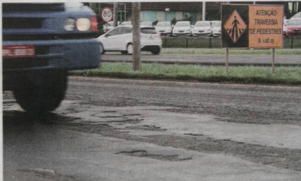
Asfalto e sinalização no trecho urbano da BR-386 deverá ser reformado
