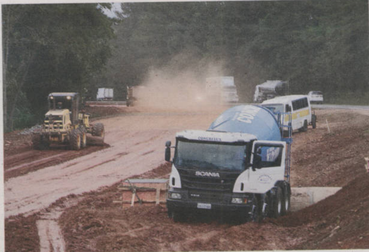
Sete quilômetros da duplicação devem ser concluídos até outubro. Depois disso, restará apenas área interditada pela Funai
