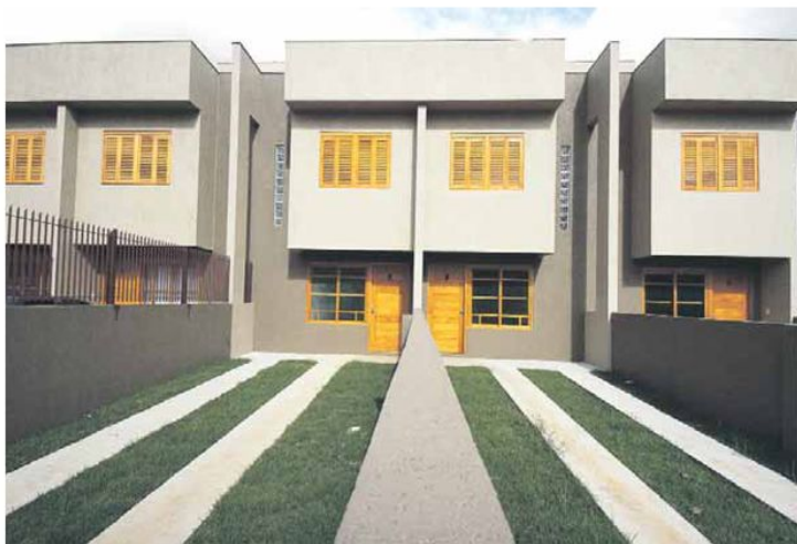
DENTRO DA LEI: construtoras afirmam que já projetam residências de acordo com a norma
