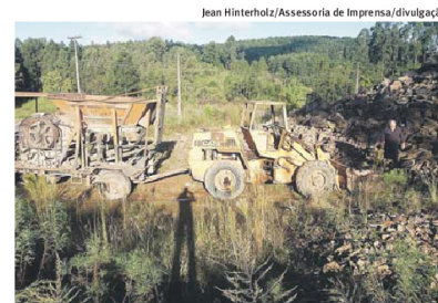
SERVIÇOS: britador foi instalado em Campo Branco
