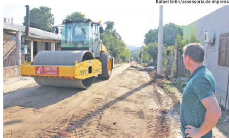
OBRAS: compactação com rolo para maior durabilidade em via do Santo Antônio
