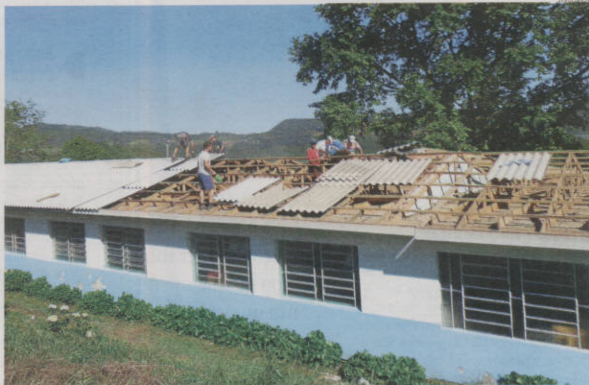
Reformas na Escola de Ensino Fundamental Ouro Preto já iniciaram. Aulas devem retornar na próxima segunda-feira
