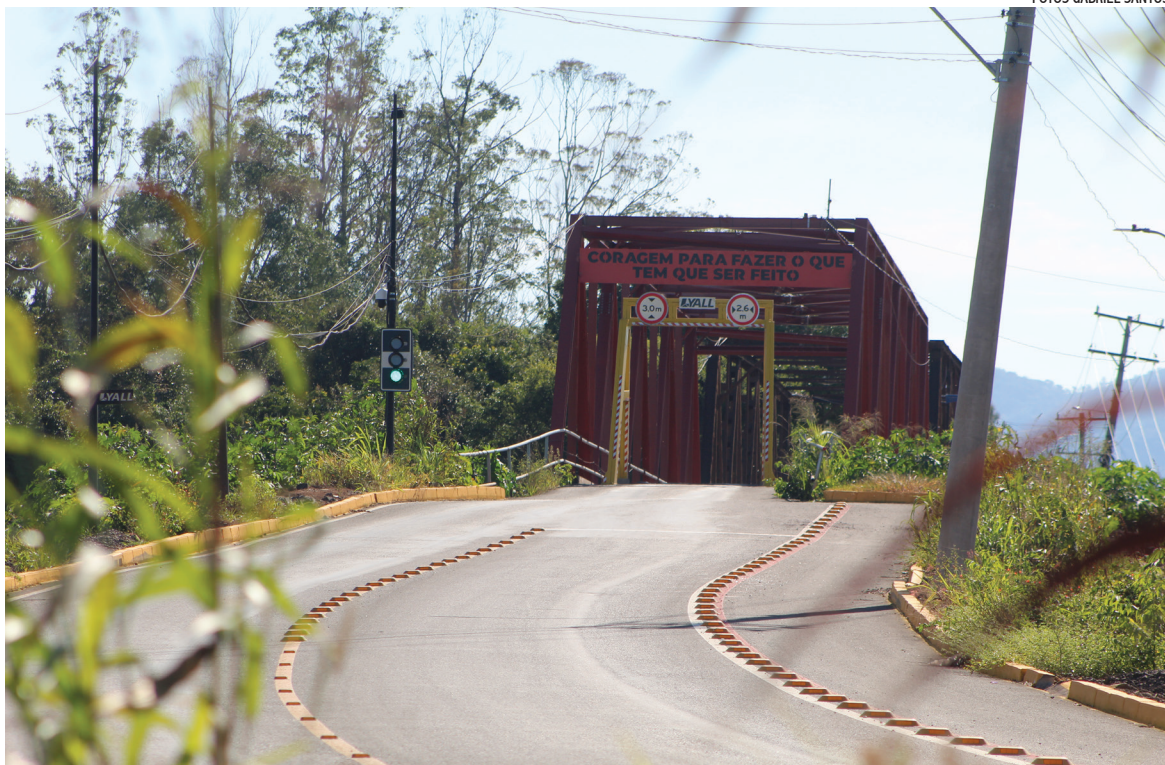
Estrutura será construída ao lado da Ponte de Ferro, sendo acessada pela Pasqualini
