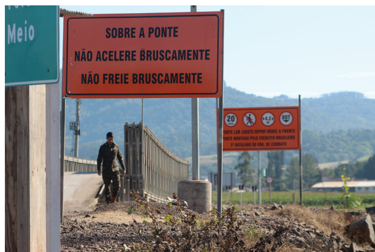
Desmontagem da estrutura metálica será finalizada semana que vem
