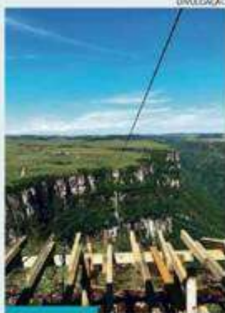
Tirolesa em construção no Cânion Fortaleza
