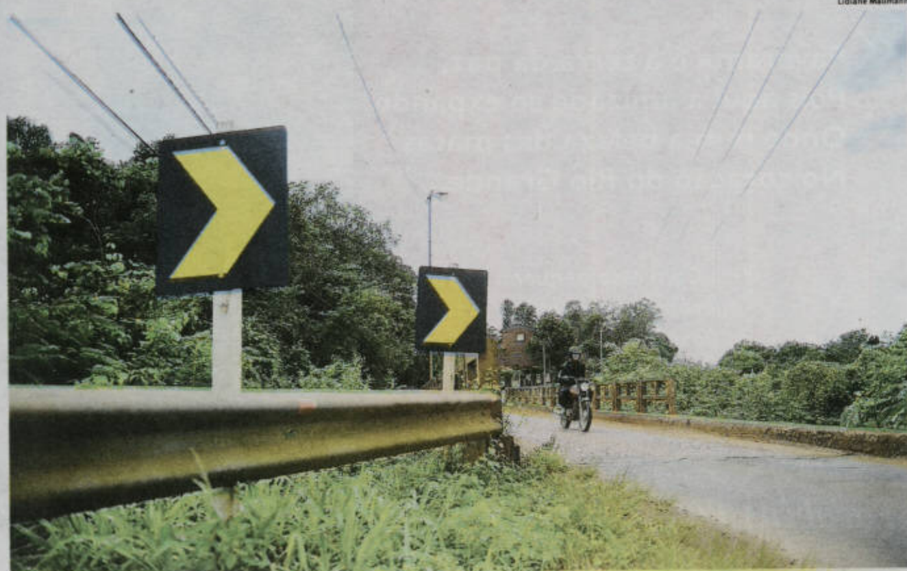
OBRA: na segunda-feira, deverá se iniciar a construção de uma nova ponte, que facilitará o fluxo de trânsito da ERS-413, sobre o Arroio Saraquá
