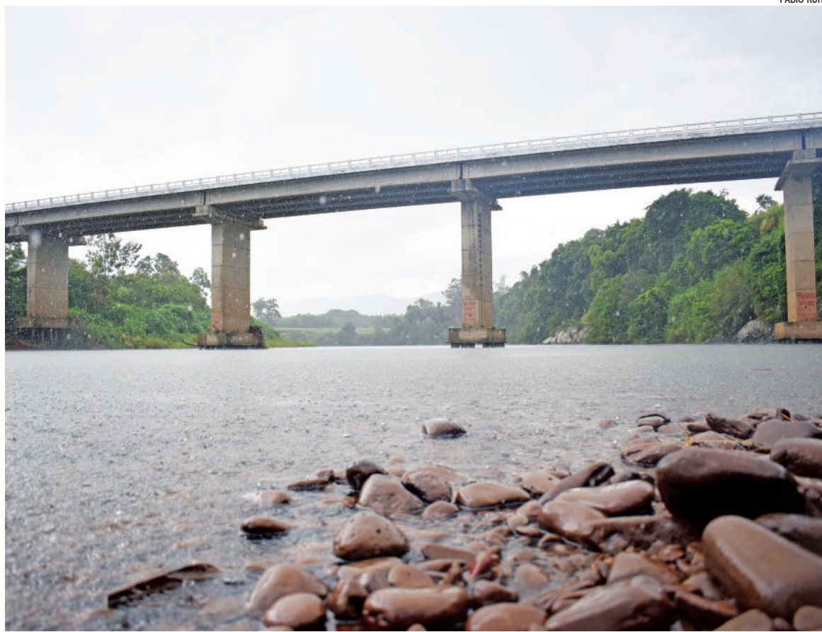
Um dos pontos que podem receber monitoramento é na ponte do Forqueta, entre Marques de Souza e Travesseiro
